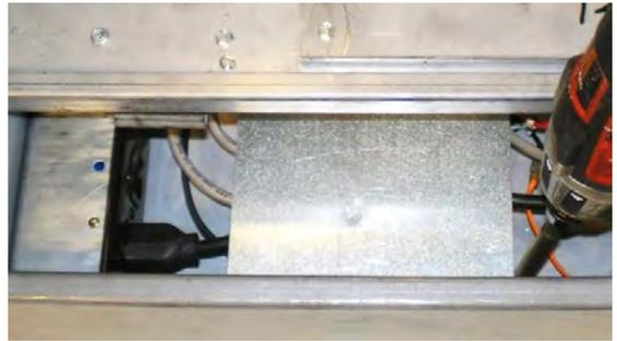
Module de contrôle de l'évent installé dans le foyer.
