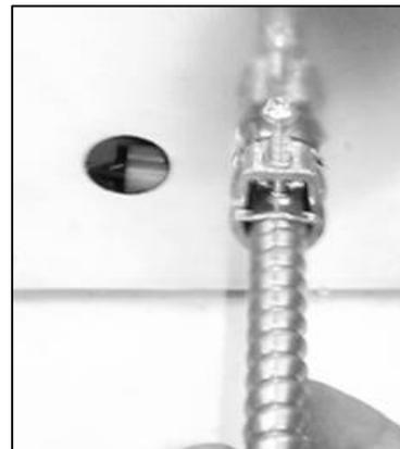
Insérez le câble dans le trou 7/8" prévu à cet effet dans l'appareil. Poussez le connecteur jusqu'à ce qu'il s'enclenche.
