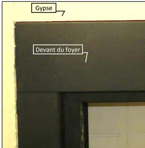
**Étape 3:** Une bordure de brique, tuile, ou autre matériau non combustible peut être installée par-dessus la façade du foyer pour dissimuler le joint.
