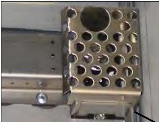
\*L'écran de veilleuse doit être inspecté visuellement une fois par mois pour voir s'il y a signe de détérioration due à l'exposition à la flamme. Remplacez si nécessaire.
