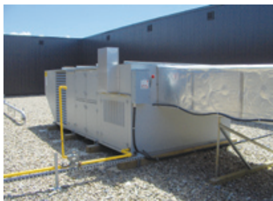
Unité de ventilation tempérée à feu indirect avec climatisation
