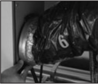
figure 7.2 Insérer la gaine isolante à l'intérieur de la double paroi du collet amovible.
