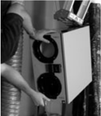
figure 6.2 En tirant sur la courroie et en soulevant l'unité, fixer à la hauteur
