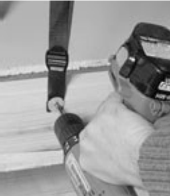
figure 6.1 Fixer les œillets des courroies aux solives à l'aide de vis (#10 x 1)
