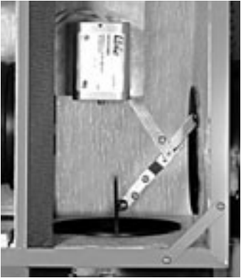
figure 8.3 - mécanisme du volet motorisé
