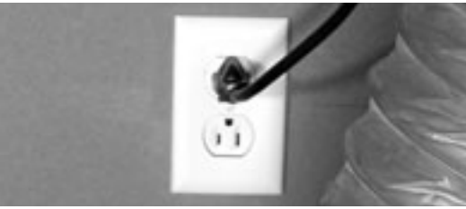
figure 10.2 Cordon électrique du VRC/VRE. Votre système est muni d'un fil de raccord pour une prise de 120 volts. Il est déconseillé d'utiliser un rallonge électrique pour connecter votre système. Si vous n'avez pas accès à une prise de courant avec un circuit distinct, il est recommandé de faire appel à un électricien pour en faire l'installation.
