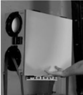
figure 6.3 Terminer l'installation en vous assurant de bien niveler l'unité.
