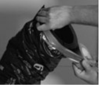
figure 7.1 Insérer le conduit en vinyle par-dessus les quatre agrafes de fixation et serrer avec un collet de serrage (30 po).
