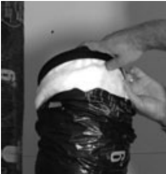
figure 7.2 Insérer la gaine isolante à l'intérieur de la double paroi du collet amovible.
