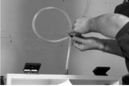
figure 9.1 Former un siphon dans le conduit.
