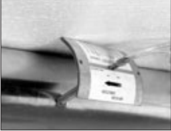
Insérer la grille dans le conduit.
