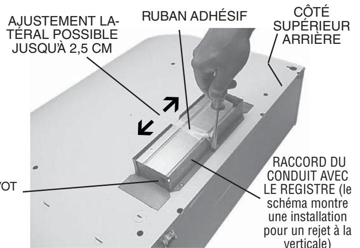
**13** Pour les installations avec un conduit de rejet d'air de 8,3 cm x 25,4 cm seulement : Retirez le **ruban adhésif** du volet du registre et fixez le **raccord du conduit avec le registre** sur l'ouverture (débouchure) choisie avec les vis que vous avez retirées lors de l'étape 4 de cette section. Assurez-vous que le **pivot** du registre soit installé près du **côté supérieur arrière** de la hotte.
